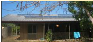
Solar arrays at Gunun Woonun
