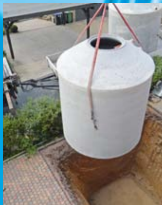
Einbringung des Eisspeichers mit einem Volumen von 12 Kubikmetern
