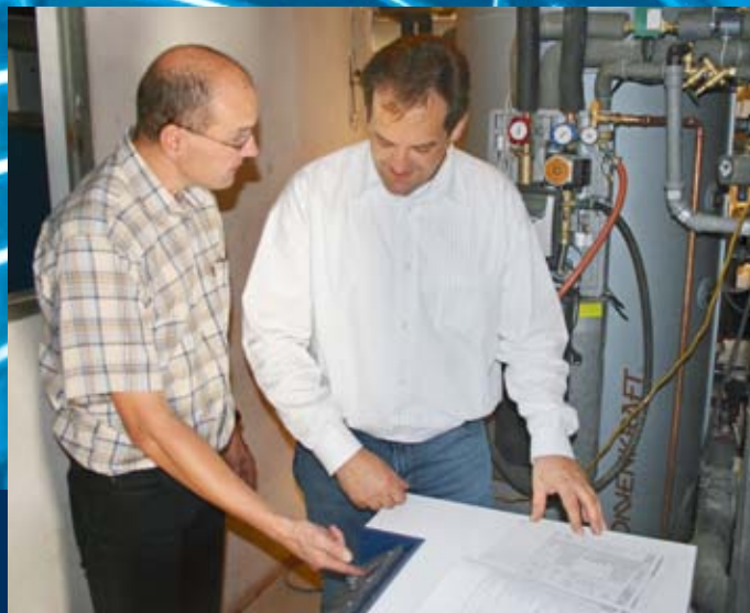
Inbetriebnahme der fertigen Anlage durch Diplom-Ingenieur Maik Zöhler (links) und Heizungsbauermeister Alexander Schackert
