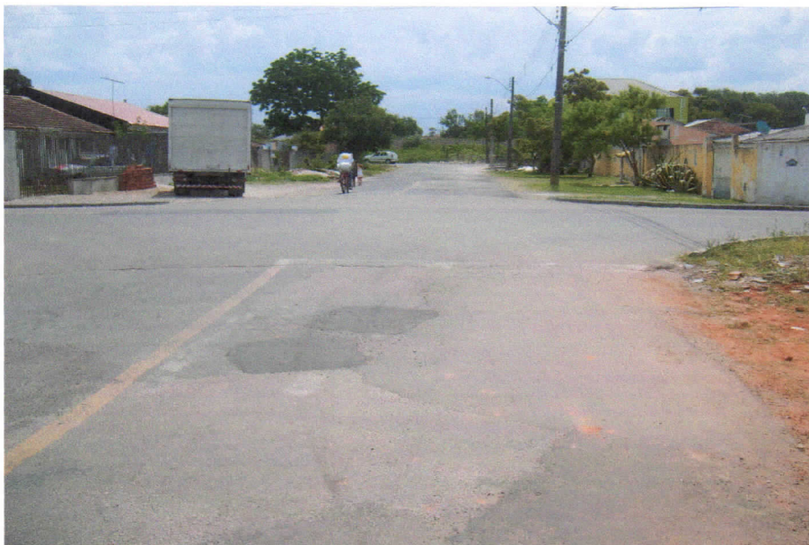
Cruzamento rua Lírio do Vale com a rua Luiz Visinoni
