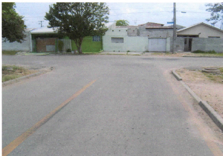
Cruzamento rua Luiz Visinoni com a rua João Alves de Araújo
