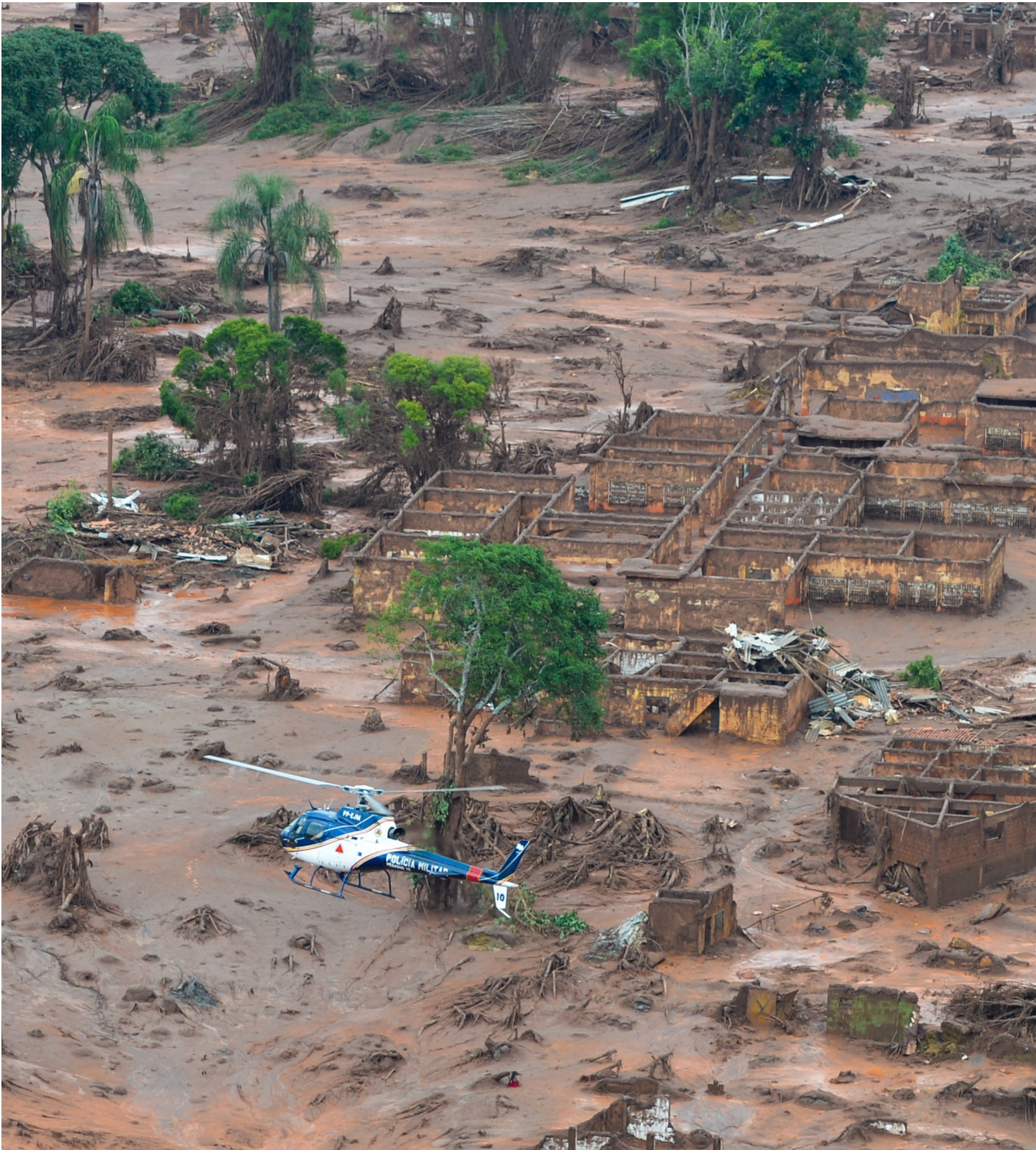
Iron ore mine waste pond break, Minas Gerais, Brazil, Photo by Agência Brasil Fotografias
