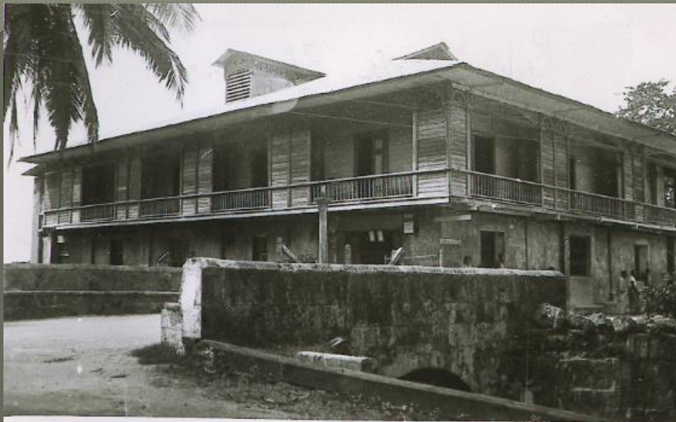
Puente de Baclayoh. Bohol. Contruido por Recoletos.
