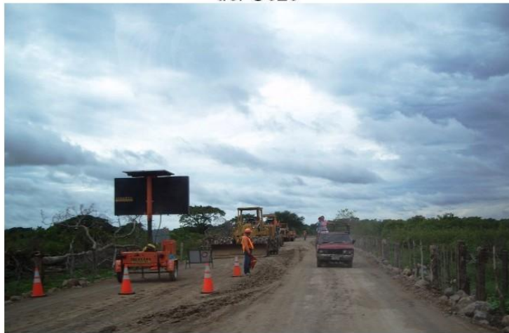
Figura 28. Construcción de calle sobre la península de San Juan del Gozo
