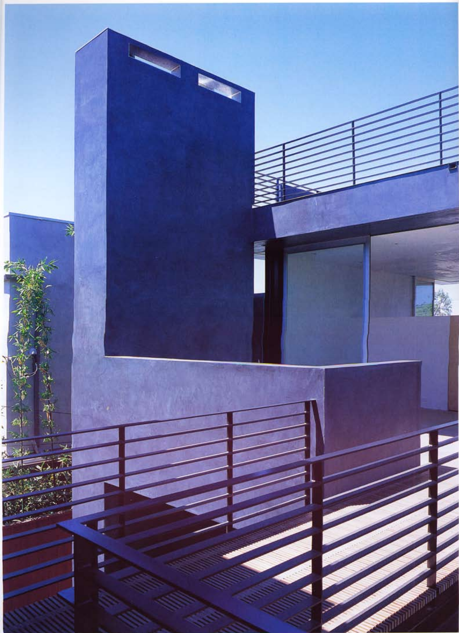
View toward patio on second floor 2階パティオ方向を見る
