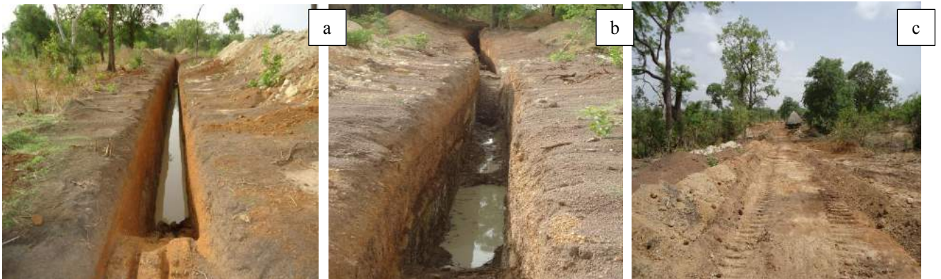
Photo 7a et 7b- Vue de la tranchée MBT-005; 7c tranchée MBT-005A après recouvrement
