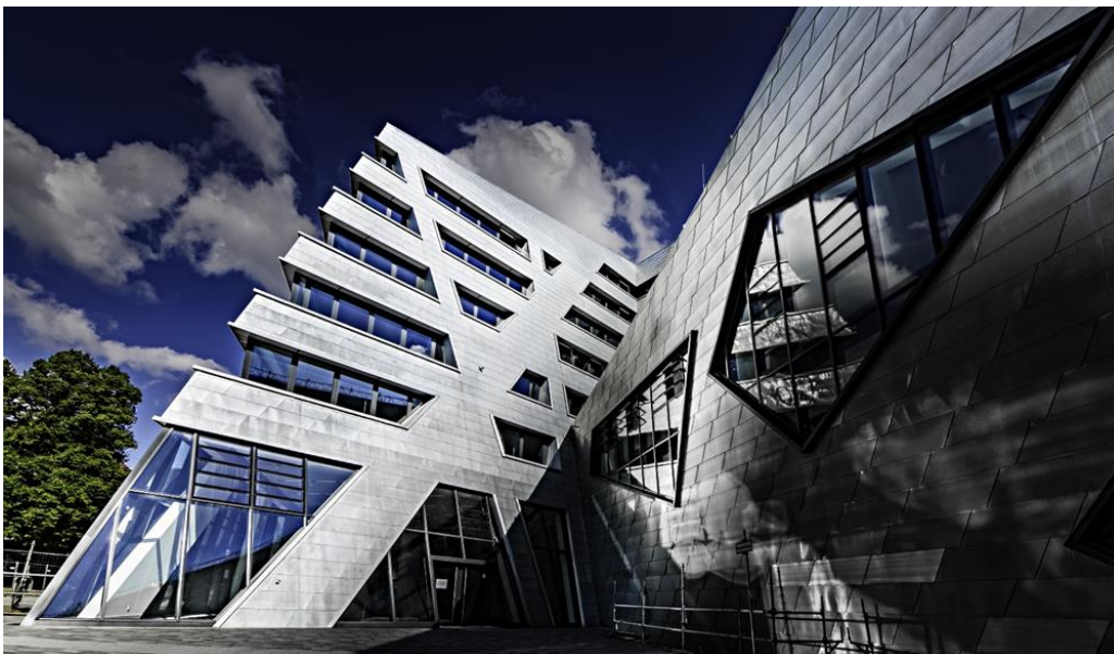
Objekt mit schaltbarer Verglasung von EControl-Glas: Leuphana, Campus Universität Lüneburg
