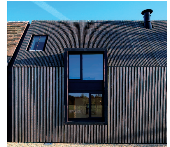
Pour obtenir une enveloppe continue du sol au faîtage, des chêneaux sont engagés sous la toiture.
