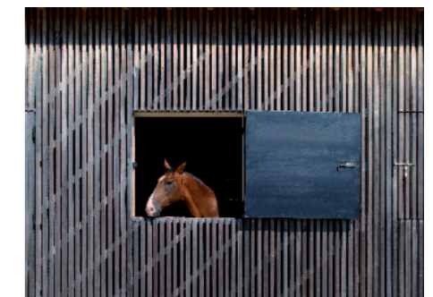
Grâce à un calepinage précis, les ouvertures des écuries sont dissimulées dans le bardage.
