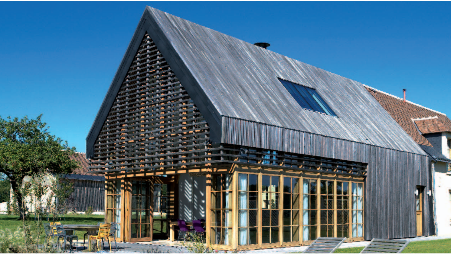
Les lames de peuplier, employées tantôt en couverture, en bardage ou en brise-soleil, distinguent les volumes ajoutés des édifices initiaux.
