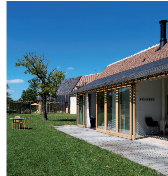
Les lames de peuplier, employées tantôt en couverture, en bardage ou en brise-soleil, distinguent les volumes ajoutés des édifices initiaux.
