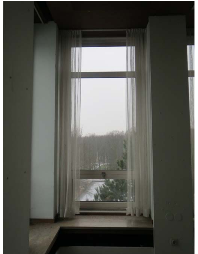
Kozijn met ventilatiestrook (bovenzijde)
