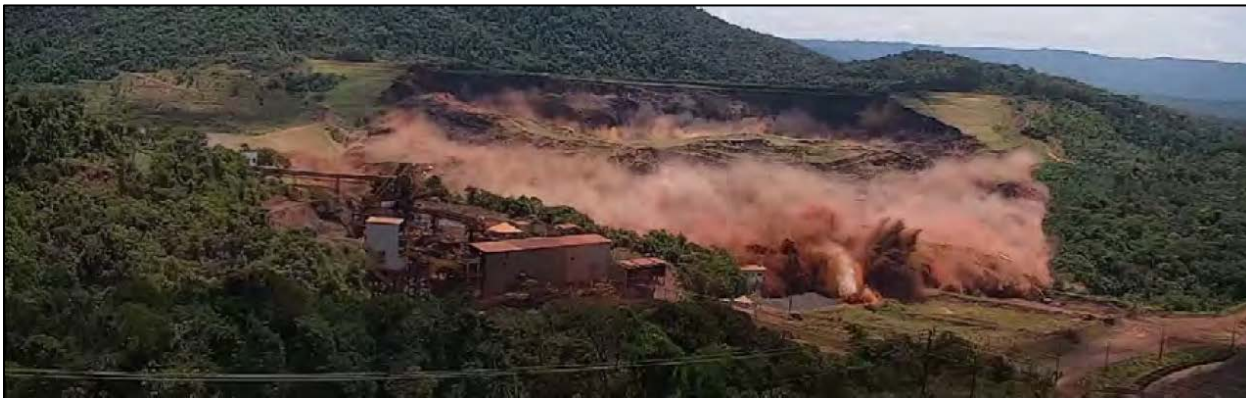
Figura 4. Falla de Brumadinho, Brazil, 18 segundos después del inicio
