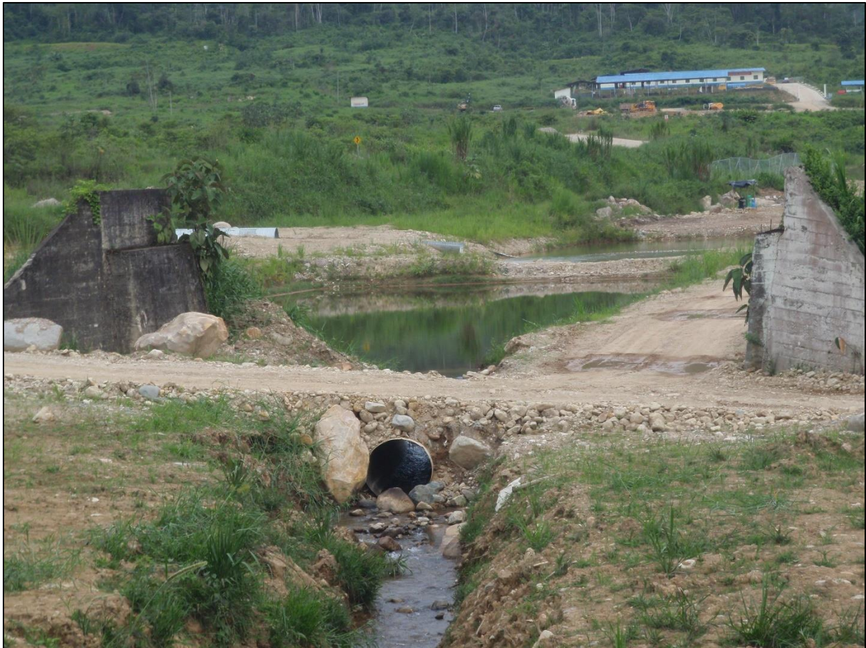
Figura 19a. El desbordamiento de las piscinas de sedimentación para la relavera Tundayme se descarga en una tubería y fluye hacia el río Quimi (ver Figura 11). Foto tomada por el autor el 6 de noviembre de 2018.
