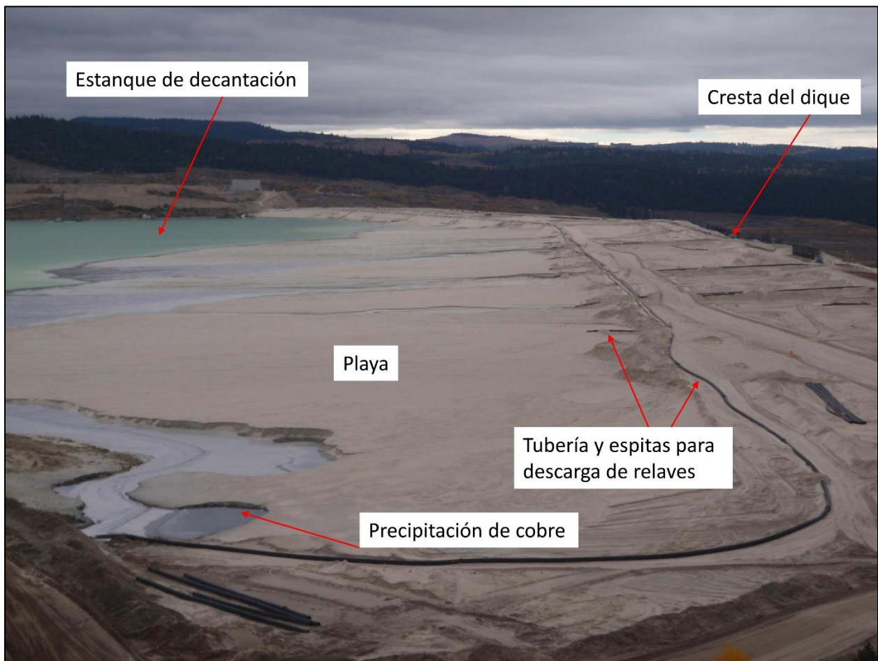
Figura 4. En la instalación de almacenamiento de relaves de la mina de cobre Highland Valley en Columbia Británica, los relaves húmedos se descargan en la dirección aguas arriba desde una tubería y espigas a lo largo de la cresta de la presa. Las partículas más grandes (arenas) se depositan cerca de la presa para formar una playa. Las partículas más pequeñas (limos) se transportan más lejos de la presa para formar un estanque de decantación. La precipitación de cobre en el estanque indica la extracción incompleta de cobre de la mena. La playa estrecha (especialmente en el lado opuesto, donde la playa es casi inexistente) hace que la presa sea susceptible de fallar por inundación. Foto tomada por el autor el 27 de septiembre de 2018.
