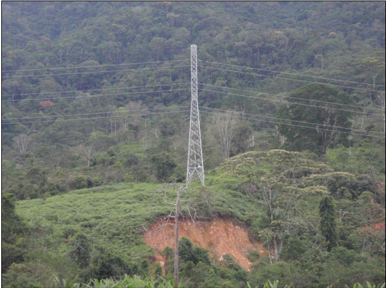
Figura 15. La alta tasa de erosión en el área del proyecto está indicada por la cicatriz de deslizamiento debajo de una torre de transmisión en la orilla norte del río Quimi (ver Figura 11), opuesto de la presa de relavera Quimi. Foto tomada por el autor el 6 de noviembre de 2018.
