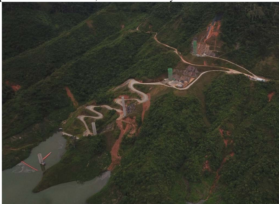
Figura 7. Torres de decantación en construcción. La torre en la parte inferior izquierda parece estar operativa. Las torres más altas en la ladera son para uso futuro. Finales de mayo de 2022. Fuente: proveedor local
