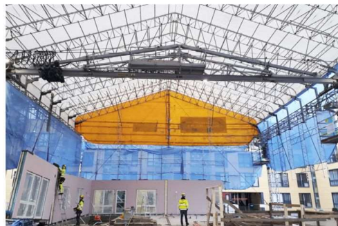
SILTANOSTURI. Puukerrostalon suurelementit nostetaan paikalleen siitanosturin avulla.
