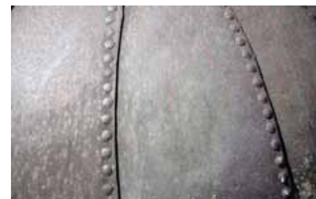
• Plaques métalliques rivetées de la chaudière
