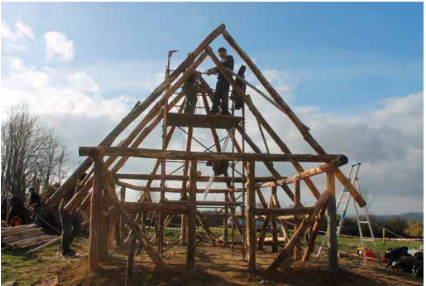
10. Ricostruzione in corso (dicembre 2015-gennaio 2016) della capanna di “Bodo il contadino”
