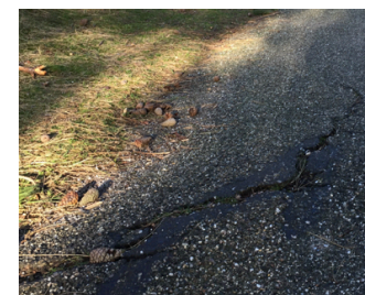
Wortelschade in een asfaltweg
