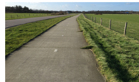
Betonpad waarvan de opstaande rand begroeiing onderhoud behoeft. De verharding zelf laat geen water door. Om plasvorming te voorkomen, is op gezette tijden bermonderhoud noodzakelijk. (Foto: Hanneke Schmeink)
