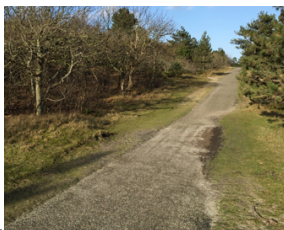
VOORBEELDEN ACHTERSTALLIG ONDERHOUD: LINKS: asfaltpad waar het gras het pad over groeit. RECHTS: schelpenpad met oprukkend gras.
