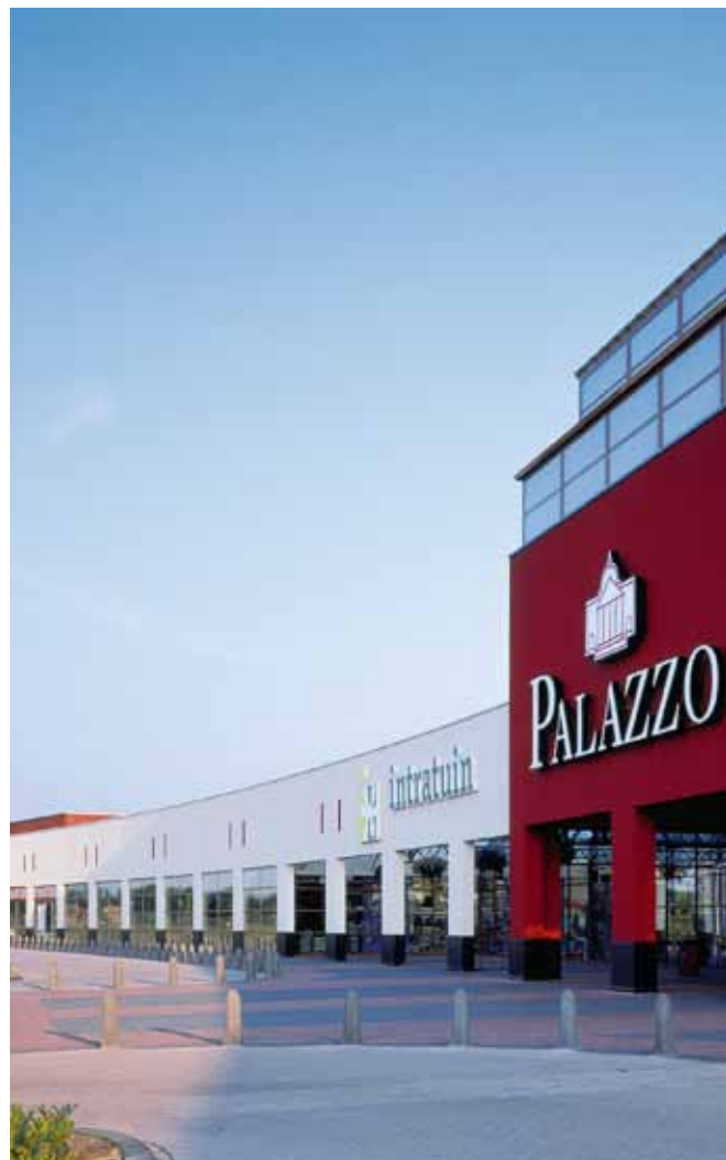
Het winkelcentrum Palazzo in Lelystad werd afgewerkt met het voegenloze systeem StoVentec Fassade. Architect: Adcom 2000, Rotterdam.
