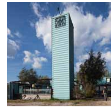
15 ZEECONTAINER RESTAURANT (2005) Architect: Bijvoet architectuur & Stadsontwerp Address: Loods Celebes 101
