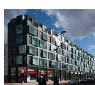
27 JONGERENHUISVESTING ZUIDERSTERBLOK (2010) Architect: Groosman Partners Architecten Address: Hillelaan 31
