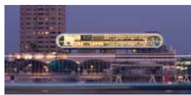
24 LAS PALMAS (2007) Architect: Benhem Crouwel Architecten Address: Wilhelminakade 332
