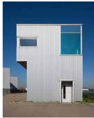
29 KANTOOR RIJKSWATERSTAAT (2003) Architect: Emiel Lamers Architectures / Rijksgebouwendienst Address: Butaanweg 1 Pernis
