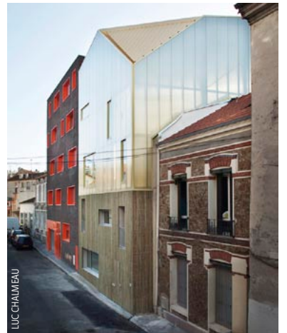
18 MAISON TRAPÈZE (2009) Architect: Louis Paillard Address: 8 rue du 18 Août, Montreuil-sous-Bois (dep. 93)
