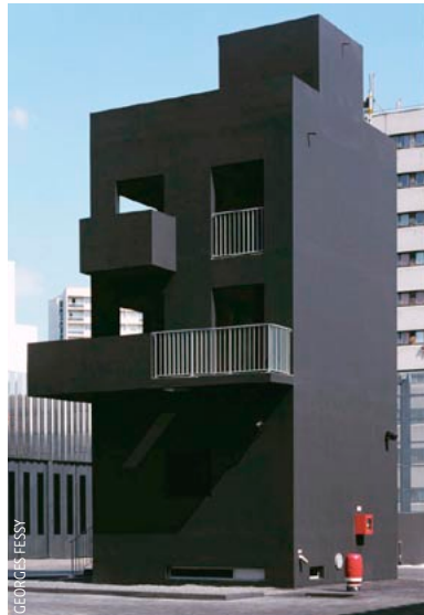
9 FIRE STATION (2004) Architect: Ibos & Vitart Address: av. de la République, Nanterre (dep. 92)
