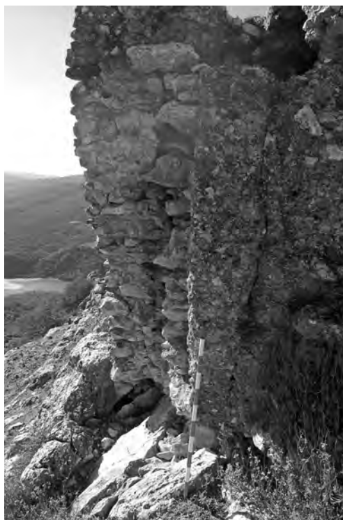
Figura 5. Aljibe y paramento
