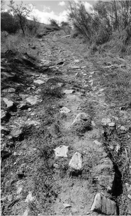
Fig. 20.-Restos de empedrado romano. Con cunetas y limitaciones laterales
