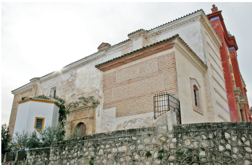
Figura 2. Vista del lado del evangelio y porche de la iglesia de San Sebastián de Cañete la Real
