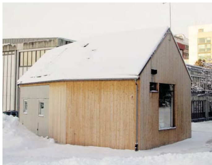
ZEB Test Cell Laboratory ligger på Gløshaugen i Trondheim og er et sentralt forskningsobjekt for flere prosjekter ved NTNU og SINTEF, også for utvikling av nye takløsninger. Foto: Tore Kvande
