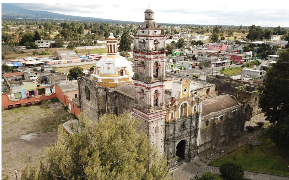
Figura 1. Panorámica del Templo y ex convento en Santa Cruz, Tlaxcala
