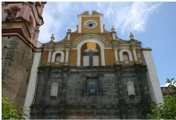
Figura 6. Segundo y tercer Nivel de la Fachada
