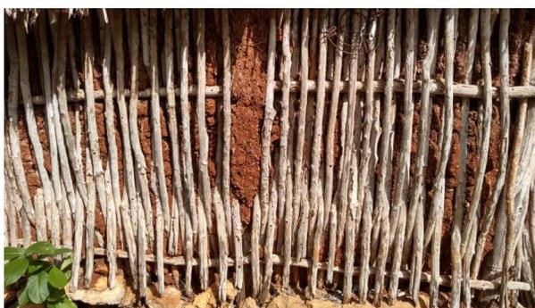
Ilustración 5. Detalle de tejido de muro (Colox-ché)
