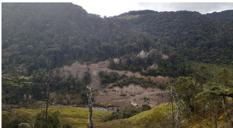
Fotografía 2 tomada por: Yudi Angélica López González. Apertura vía San Juan sobre el río las Vegas. Vereda las Vega., San Bernardo Cundinamarca 2019
