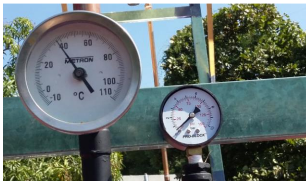
Figura 6.- Instalación de la tubería con sus instrumentos de medición de temperatura y presión.
