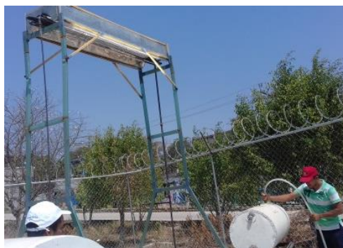
Figura 8.- Instalación del sistema de almacenamiento del Concentrador Solar Lineal tipo Fresnel.
