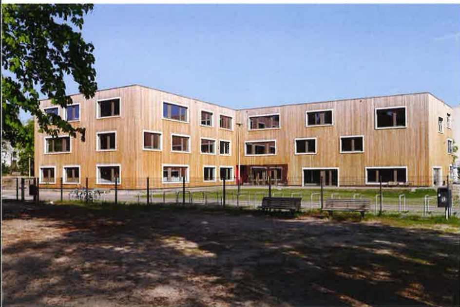
Foto: Kerstin+Kopp Architekten
