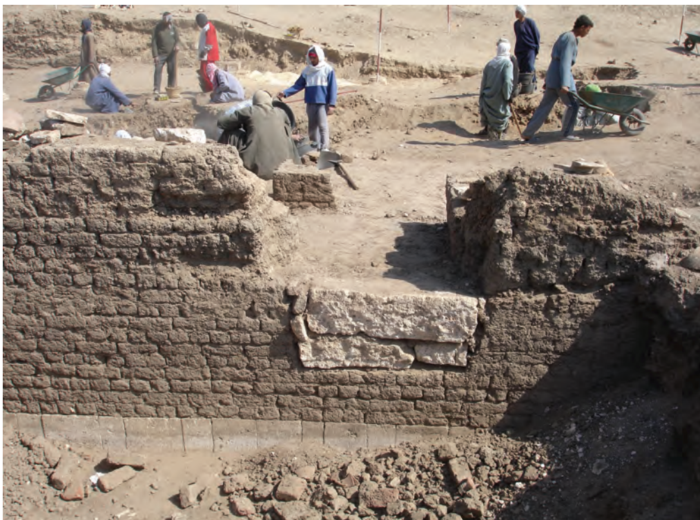
Photo 2. Später eingebrochene Tür in Raum 5 mit anschließender Vermauerung.
