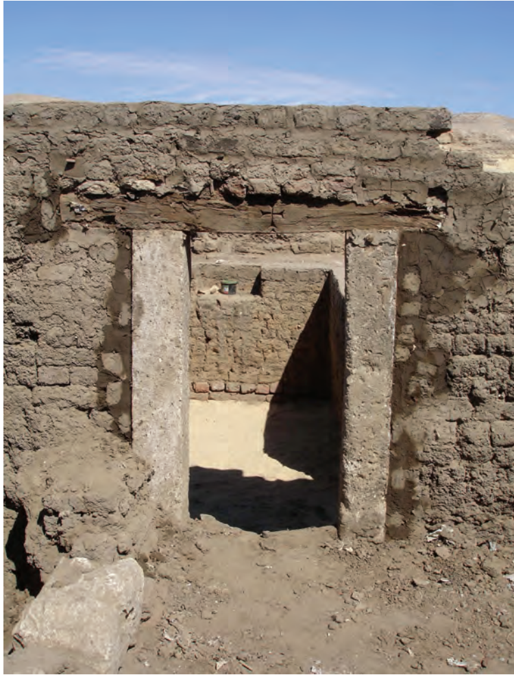
Photo 1. Westlicher Eingang in Raum 2 mit Holzsturz.
