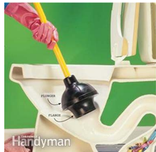
Figure 8 : Utilisation du débouchoir à ventouse pour toilette
