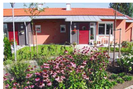
Passivhuset i Glumslöv har en meter långa takutsprång, som med sin skugga dämpar solvärmestrålningen under sommarhalvåret.
