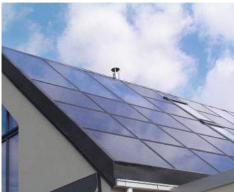
Plusenergihuset Villa Åkarp, med sina 18 m 2 solfångare och 32 m 2 solceller. Solcellerna producerar mer el än vad huset gör av med.
