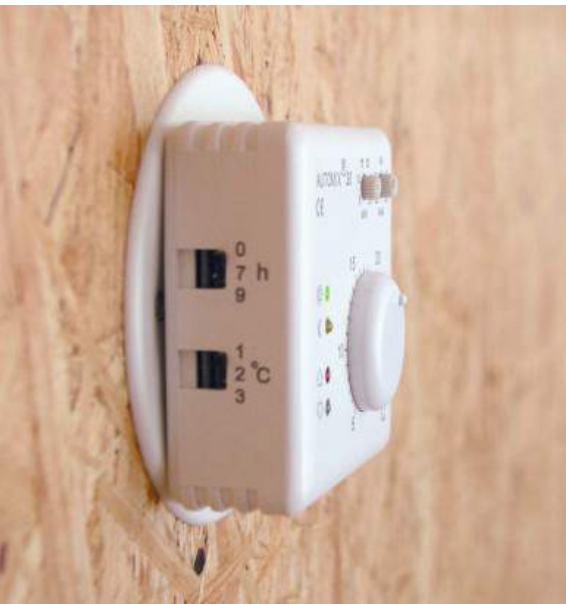
Ute och innegivare: Mäter temperaturen och kommunicerar med värmesystemet så att den givna temperaturen i rummet ska bli rätt.
