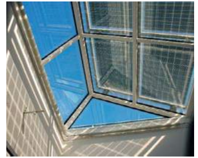
Solceller kan användas som solavskärmning till exempel som markiser eller uterum
