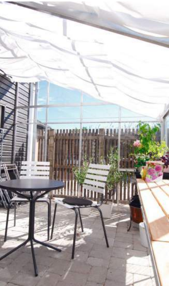
Ett fasadväxtbus ger ett extra värmetskott från den instrålade solen och fungerar som en värmesluss mellan ute och inne.
