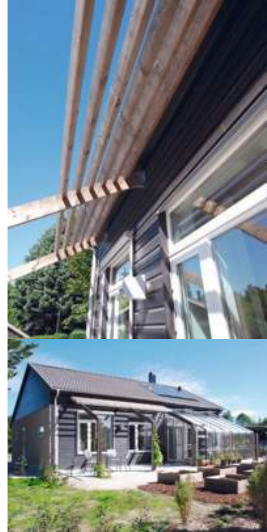
Villa Trift 3.0 – lågenergihus i Lund. Huset som är byggt i lättbetong är Sveriges första miljömärkta hus.
