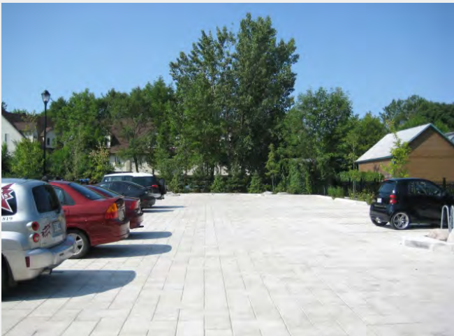
[Image de gauche : Revêtement en pavés de béton dans le stationnement du pavillon touristique de Belœil, crédit : Objectif Paysage] [Image de droite : Revêtement en pavés de béton drainants dans le stationnement de l'Aréna Rodrigue-Gilbert à Montréal, crédit : arrondissement de Rivière-des-Prairies - Pointe-aux-Trembles]
