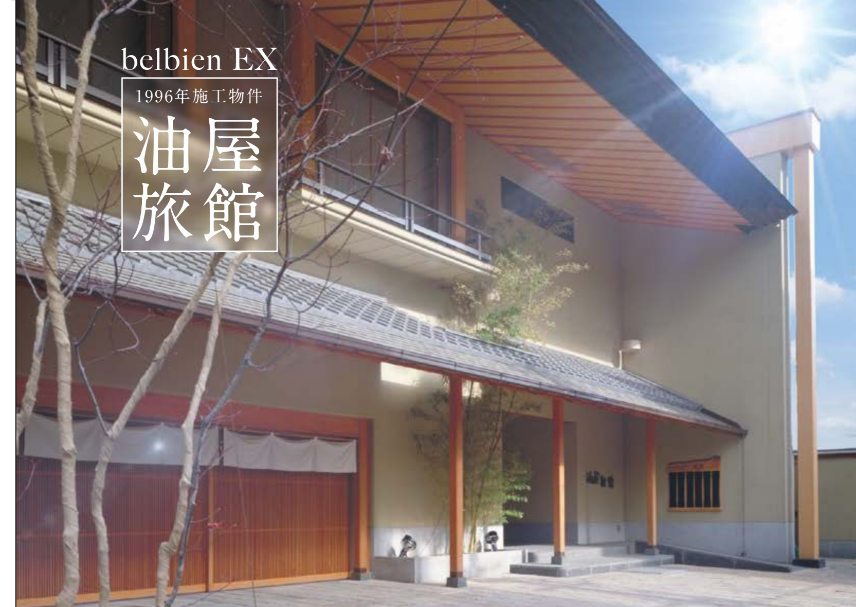
Photo : Nacasa & Partners Inc.
