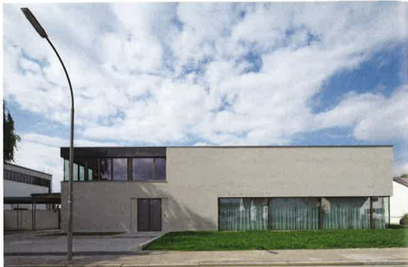
Das Pfarrheim Herz Jesu in Ingolstadt wird durch den Materialmix aus Sichtbeton, Glas und Holz geprägt.
