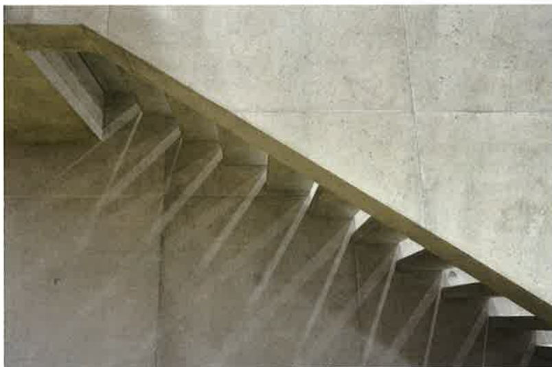
Das Gebäude ist als Stahlbeton-Massivbau konzipiert.
