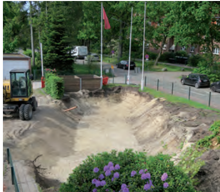
Baugrube für das Löschboot auf dem Außengelände, Foto: FMSH
