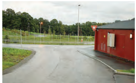
Utkjøring fra Brenneveien i Gml Lommedals-vei gir trafikkfarlig dårlig oversikt pga SVAs Teknisk bygg.
