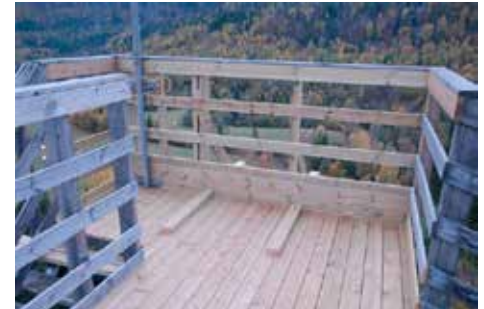
- Ny platting og deler av rekkverk er skiftet på avsatts 5 og 7.
