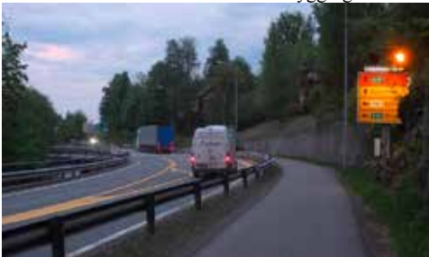
E16 Nattetraffikk ved stengte Skui og Brenne tunneler skaper nattestøy for beboerne langs Ringeriksveien på grunn av manglende styrings-system for to-veitraffikk i tunnellop. Dette er trafikken som nye E16 skulle fjerne.
