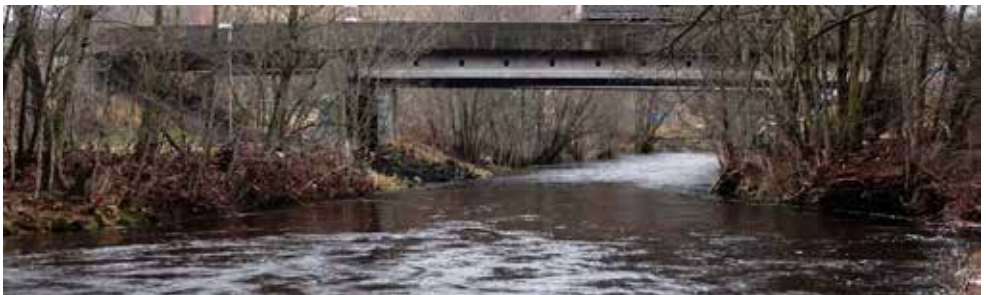
Agnes bro. Ny E16 vil gi en ny Agnes bro som ikke virker oppstuvende ved flom slik den gamle gjør. Lommedalkrysset har imidlertid fjernet Lommas flomløp og E16 over Vøyenenga reduserer flomarealet. Totalt vil denne bit for bit nedbyggingen av flomareal medføre økt fare for skadeflom oppstrøms.
