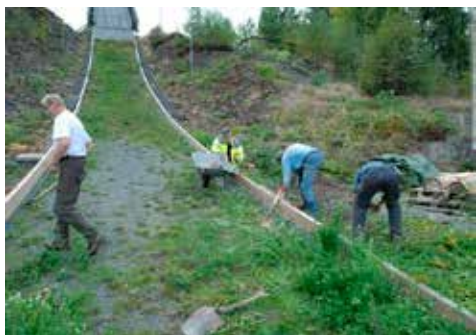
Raking og tilsåing av overgang og hoppet etter at vanger var skiftet ut i 2013.
