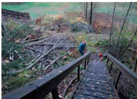
Hugging rundt trappene for å fjerne fuktighet
