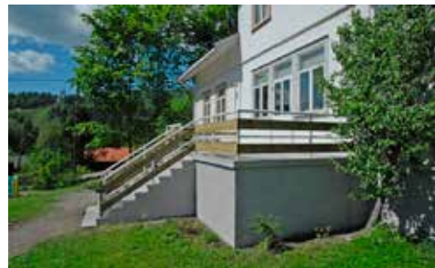
Terrasse trapp og grunnmur er rehabilitert
