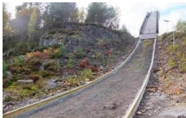
Nye prepareringsvanger ferdig .
