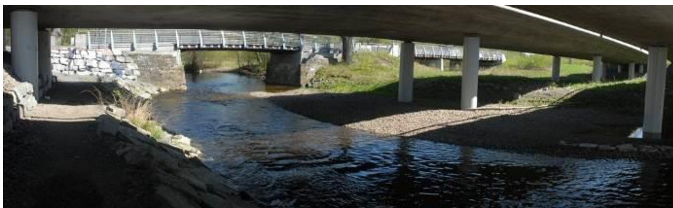
Ny Kølbru har gitt mindre oppstuvning av flomvann oppstrøms og redusert flomfaren.
