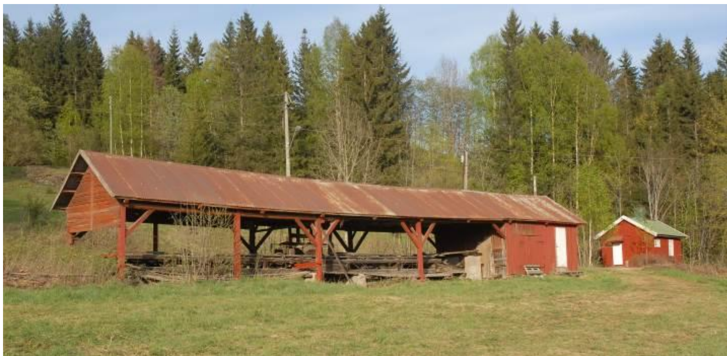
Isi gårdsag er en relativt godt bevart og stor sag med to parallelle sagbaner..
