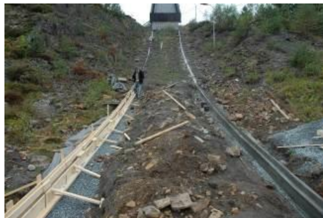
Nye preppevanger bygges. Støping av fundament og montering av trevanger.
