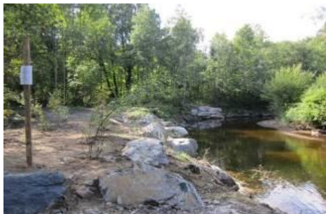
«Langhølja» Reparasjon av erosjon av flomløp med hastighetsdempende buner. - Foto: Ole Kristian Johansen (BK).
