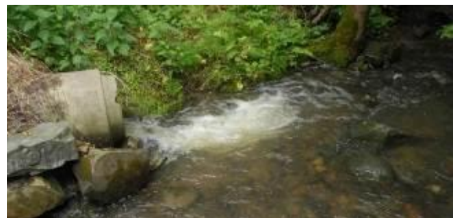
Daelsbekken lagt i rør fra E16. Tunnelvannet fra E16 må renses og bekken åpnes der det ikke er i konflikt med jordbruksdrift.
