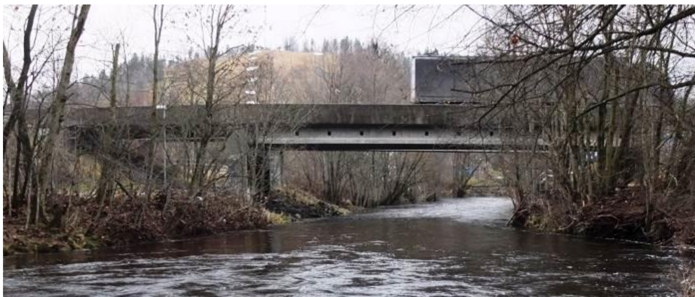
Agnes bro. Ny E16 vil gi en ny Agnes bro som ikke virker oppstuevende ved flom slik den gamle gjør. Det samme gjelder Tangen bro som skal bort når Bærumsveien som legges om.
