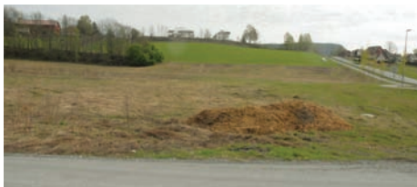
Jordet ved Økri krysset ligger fortsatt brakk etter manglende rehabilitering etter E16 utbygging.
