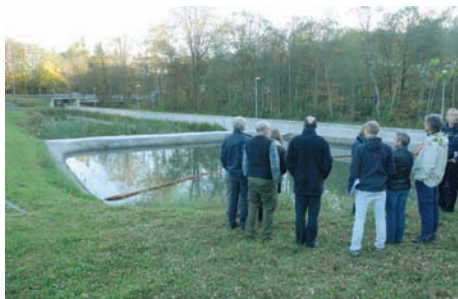
Renseanlegg ved Løxa for overflatevann og utslipp fra Rud.
