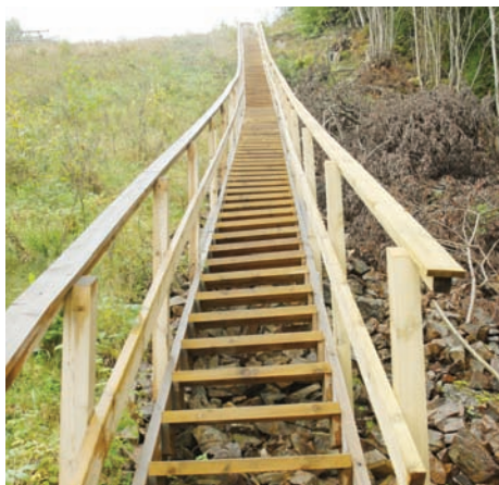
Nordre måle- og trimtrapp er restaurert og har fått rekkverk på begge sider.
