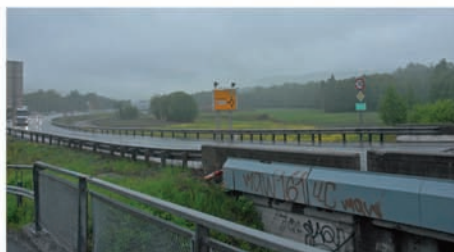
Sandviksvassdragets flomarealer spises opp av harde flater og utbygging fra Vøyenenga og nordover samt veifyllinger til E16. Den bør gå på stolper.
