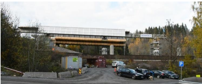
Innelukket «støpe fabrikk» er brukt for bygging av de to nye Bjørum Sag broene.
