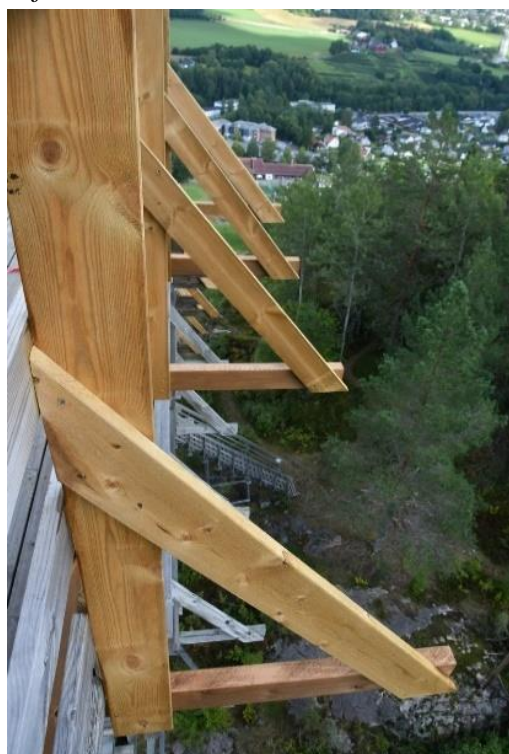
Over: Utvendig støttebjelke med gjennomgående bolter er byttet ut. Under: Utkragere og skråstøtter for rekkverk er skiftet
