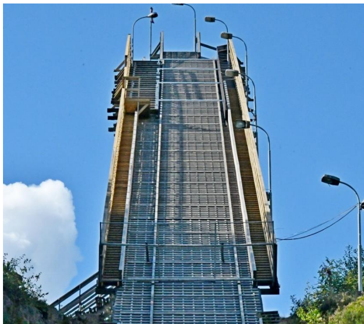
Ny Rekkverk og utkragede trapper på begge sider av tilløpet er skiftet ut.
