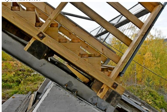
Over: Utvendig støttebjelke med gjennomgående bolter er byttet ut. Under: Utkragere og skråstøtter for rekkverk er skiftet
