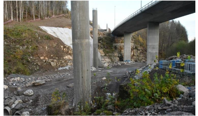
Ny E16 bro ved Bjørum Sag. Isielva er lagt i tre store rør under bygging av to nye broer og rivning av E16 broen fra 2009.
