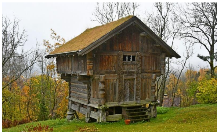
Stabburet på Ståvihøgda er fra Langlim i Telemark er bygd i 1795. Flyttet i 1946.
