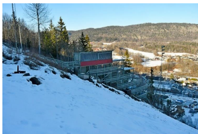
Ikke bare de store granene nord for hoppet, men også store graner og tørrgraner som truet tribuner, flomlysanlegg og kraftledningen nord for tribunen, er fjernet
