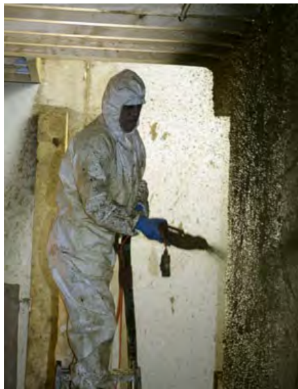
Die 2. Schicht Lehm wird gespritzt.
