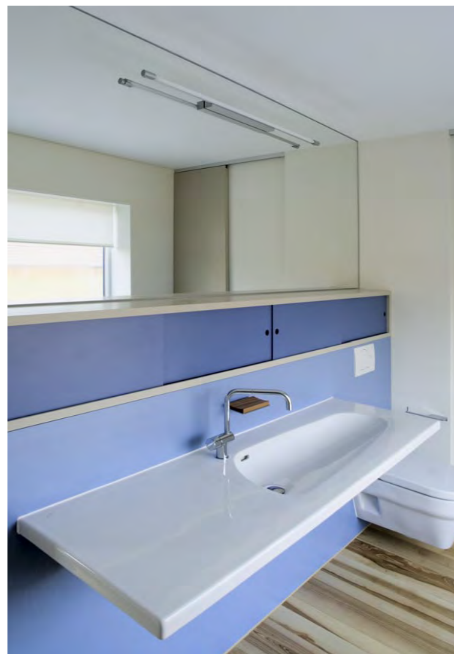
Bäder mit Massivholz-Eschenboden geölt – Wandverkleidung mit farbigen Hochdruck-Schichtstoffplatten
