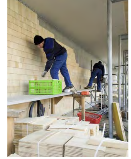
Anbringen der Schindeln.
