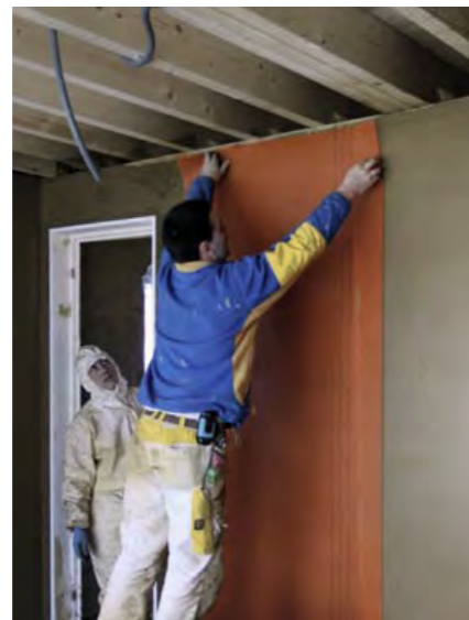
Ein feinmaschiges Netz wird auf die 2. Lage Lehm gelegt ...
