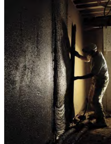
Die 2. Schicht wird glatt gestrichen.
