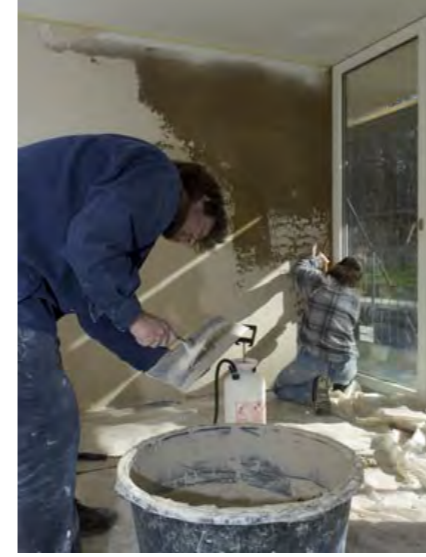
Aufbringen des Deckputzes, der mit Naturpigmenten versetzt ist.
