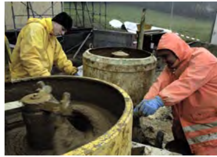
Lehm wird vor Ort mit Sand, Hanf und etwas Bentonit vermischt.
