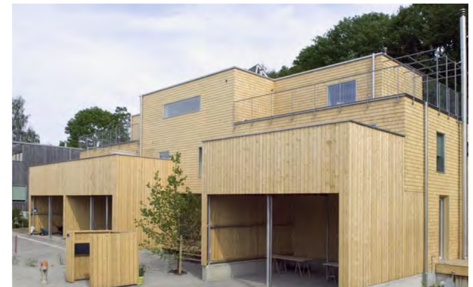
Ineinandergreifen der Schindelfassade und des Autounterstandes mit Terrasse im OG mit senkrechter Schalung in Fichte/Tanne
