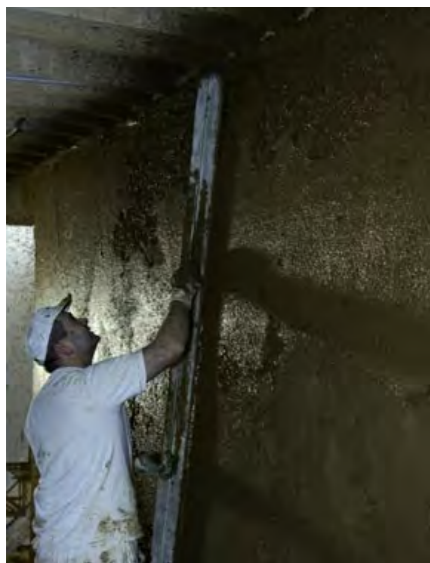
Die 2. Schicht wird glatt gestrichen – Holzbalkendecke in Mondholz
