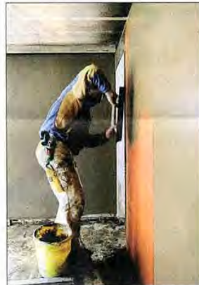
Die letzte Lage Lehm als Verputz.
