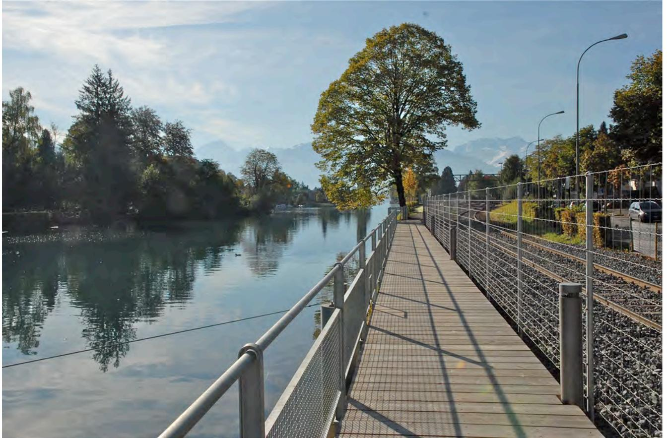
Abb. 3: Der Steg im Abschnitt «Schiffahrtskanal»; rechts am Zaun die Pollerleuchten
