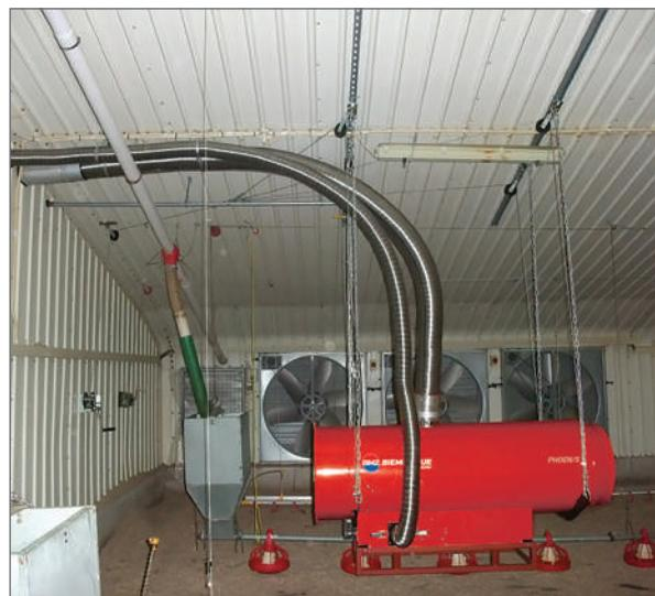
**PHOEN/S - INDIRECT COMBUSTION SUSPENDED SPACE HEATERS
