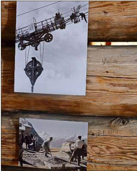
Der Kraftwerks- und Strassenbau brachte Arbeiter ...
