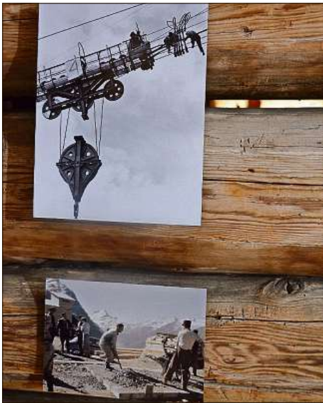
Der Kraftwerks- und Strassenbau brachte Arbeiter ...
