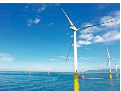
現在33基の風車が稼働中。2030年までに、あと100基以上の建設が計画されている。洋上風力発電の建設に適しているとされる、日本海の年間を通した風の強さや風車の据付けに適した海底の地形を生かした先進的な取り組み。 写真協力:秋田洋上風力発電株式会社
