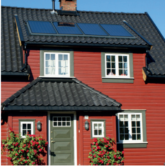
ENEBOG I ASKER MED 9 KVM PLANE SOLFANGERE INTEGRERT I TAK.
