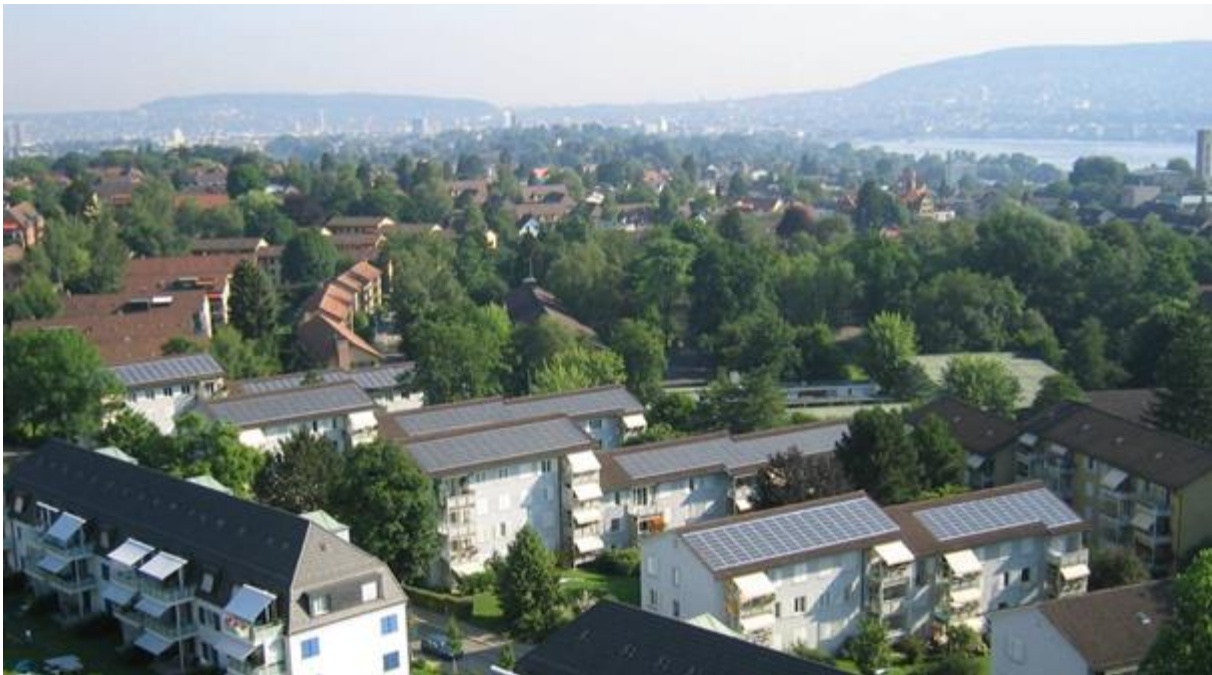
Dette borettslaget i Sveits har solcelleanlegg på 11 av 14 bygninger med samlet installert effekt på 97 kWp. Foto: Ernst Schweizer AG
