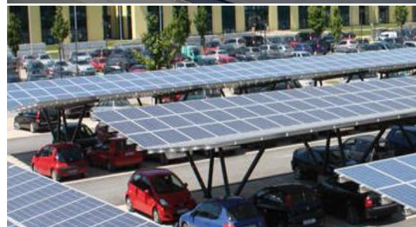
Solcelleanlegg på flatt tak. Foto: Fusen. Solcelleanlegg som overbygg over parkeringsplasser. Foto: Solkompaniet.se.
