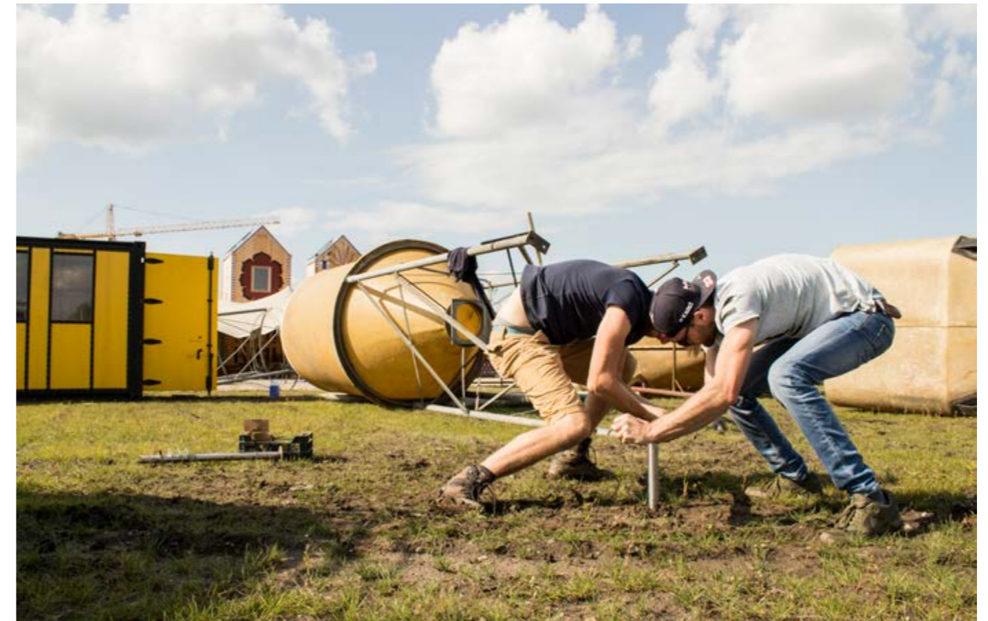
~Met een team van creatieve bouwers worden de silo's verankerd door middel van grondpluggen.
