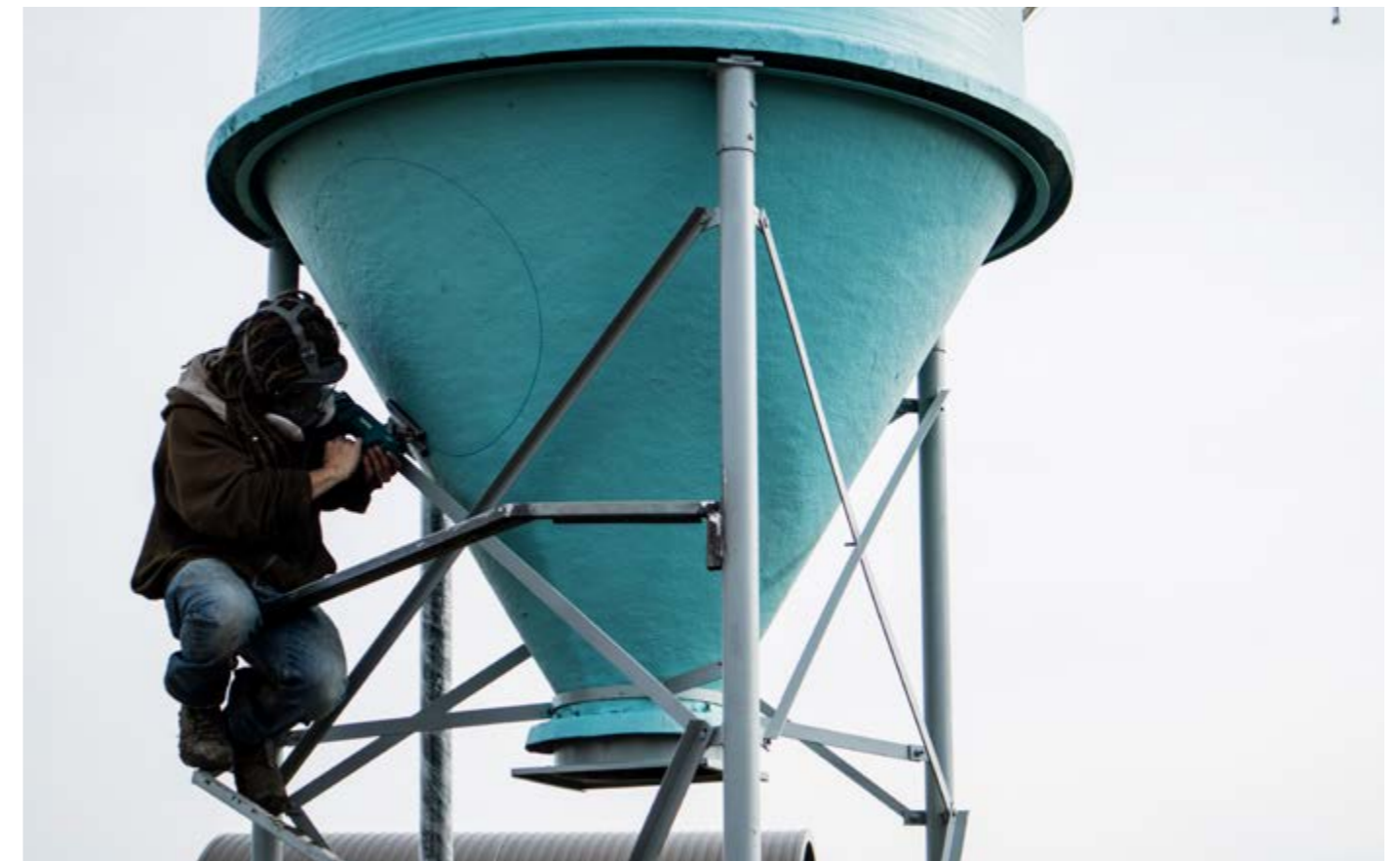
~De koffiesilo met luifel is in aanbouw. Dit is een van de grote behoeftes uit de wijk.
